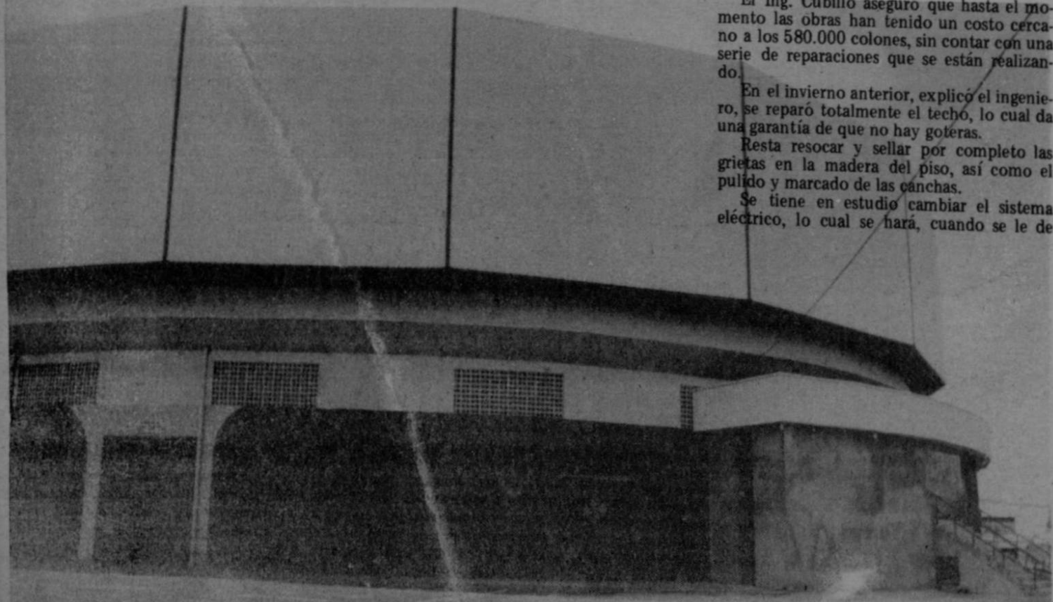
El Gimnasio Nacional con su nueva cara, después de que fue pintado, tanto por dentro como por fuera. Se observa también la construcción de las nuevas baterías sanitarias a un costado del edificio. (Foto J.C. Ulate).
